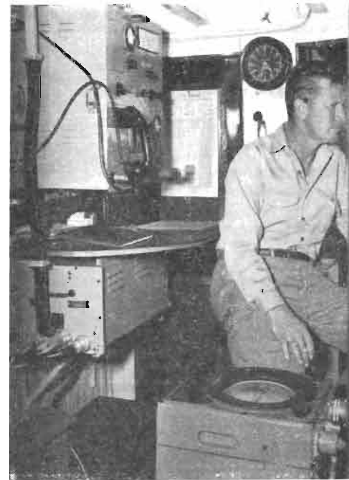
Apparecchiatura radar di costruzione Raytheon montata a bordo del «Eileen Ross».
